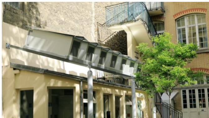
Para-PM installés dans la cour de l'école de la Victoire
